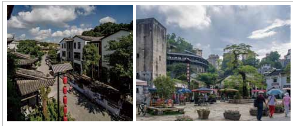
图6 小镇改建后现场照片
