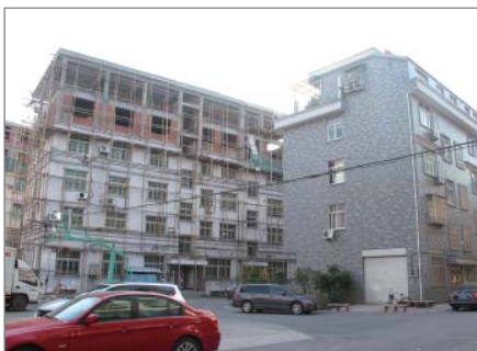
图4 城店村已基本完成住宅由四层半加升至六层
