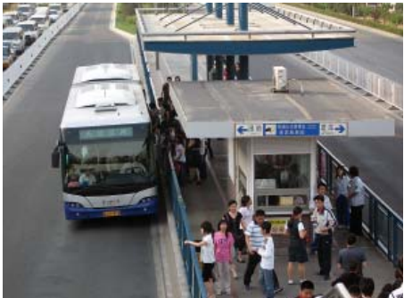
图 4 北京南中轴 BRT 系统站台
